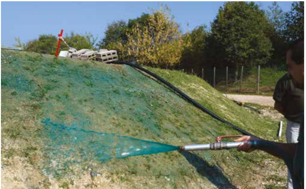
Idrosemina di miscuglio di semi autoctoni su piccolo terrapieno. Il colorante verde serve a vedere meglio la porzione già seminata
