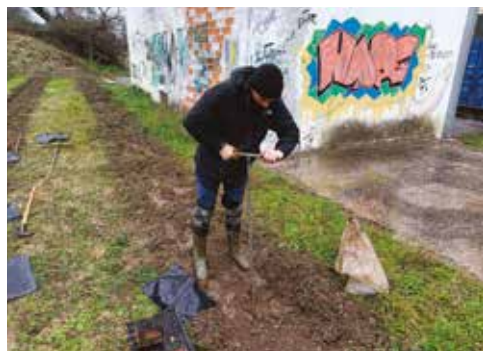
2. Realizzazione della buca tramite l'utilizzo di strumentazione meccanica manuale o di una trivella a motore
